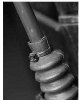
ジャバラの先端をタイラップで固定すれば、防水効果はアップする。
